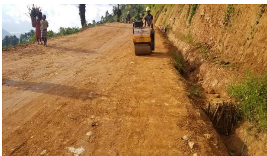
Figure 14: Route de dessertes agricoles réhabilitée dans le ZS de BUNYAKIRI
