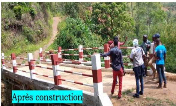
Figure 21: Pont construit à BUNYAKIRI
